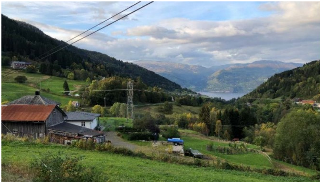
Figur 30: Bildet viser dagens 300 kV kraftledning som ligger tett på bebyggelsen i Åfet/Feios. Kilde: Multiconsult, 2023.
