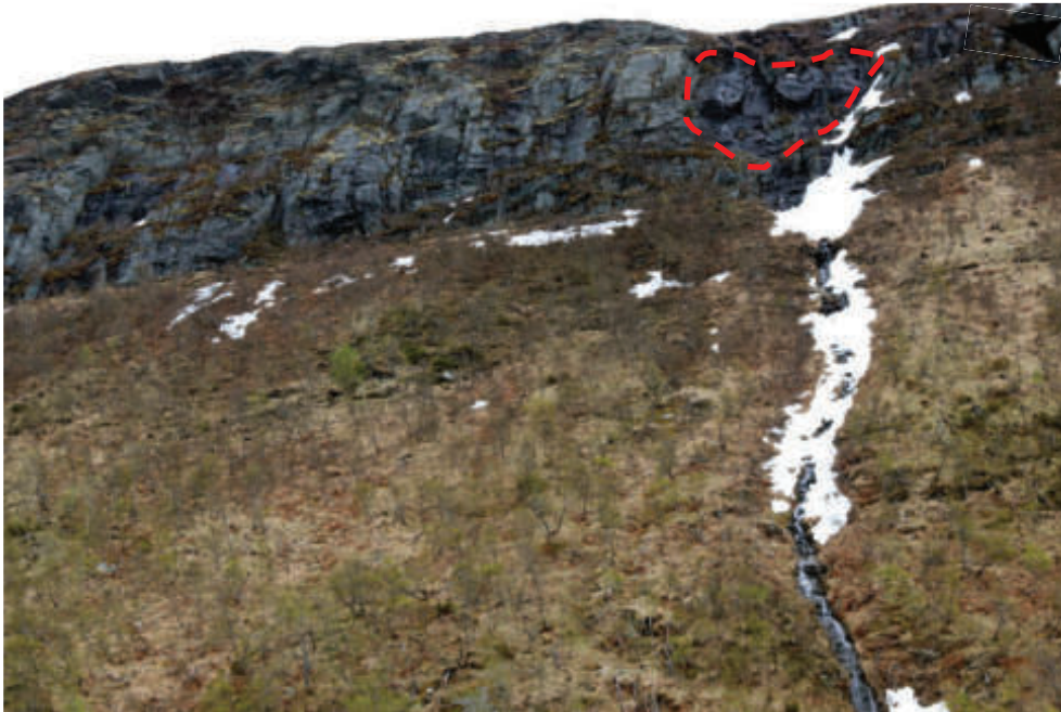
Figur 3-4. Potensielt utløsningsområde for steinsprang i fjellsiden øst for dagens koplingsstasjon med årlig utløsningssannsynlighet 1/10 markert i rødt. Generelt er det høy oppsprekkingsgrad over hele skrenten.
