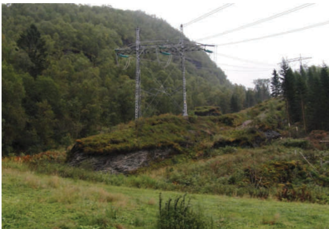
Figur 3-11 Mulige steinsprangblokker innenfor Alternativ Nord (B). Øvre bilde er tatt direkte øst for dagens koplingsstasjon. Nedre bilde, antatt steinsprangblokk til høyre for masten.
