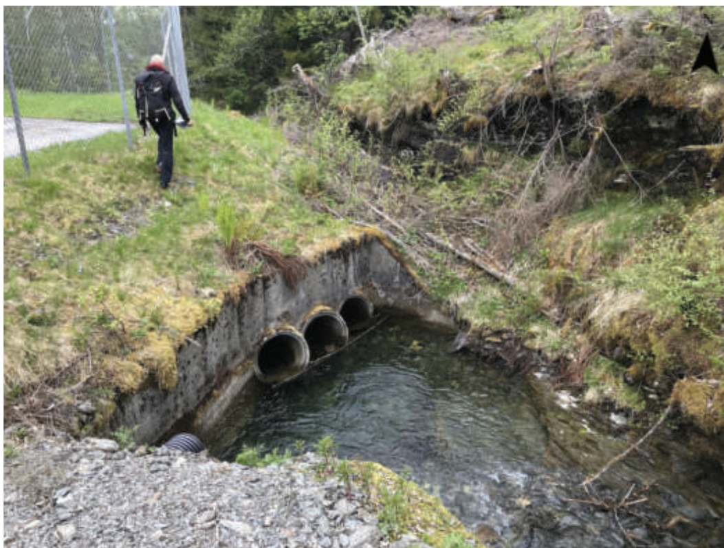
Figur 2-15 Bekk er ledet gjennom rør under sørøstre hjørne av dagens stasjonsområde (Alternativ Nord (B)).
