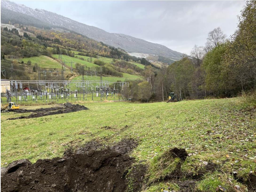
Figur 2: Refsdal koblingsstasjon slik den er i dag.
