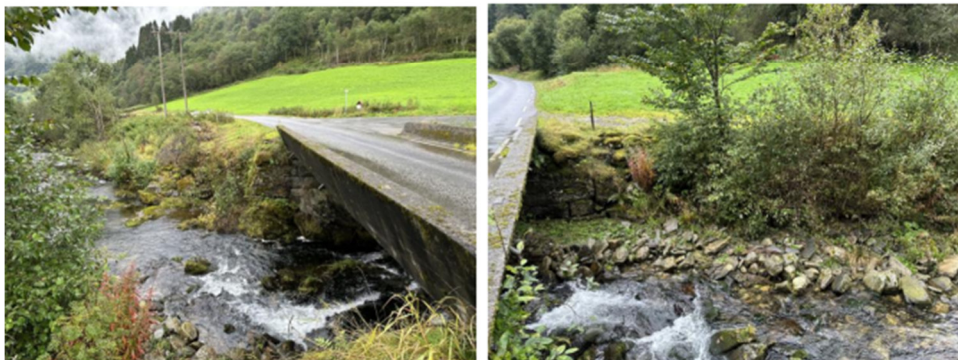
Figur 17: Ovrisdalsbru over Vikja. Kilde: Sweco, 2023.
