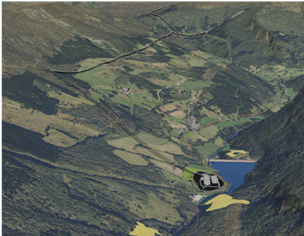
Figur 6 Figuren viser omsøkt trase for 420 kV kraftledning gjennom Ovrisdalen. Ny Vik transformatorstasjon og masselager vises i forkant av bildet. Kilde: Sweco, 2024
