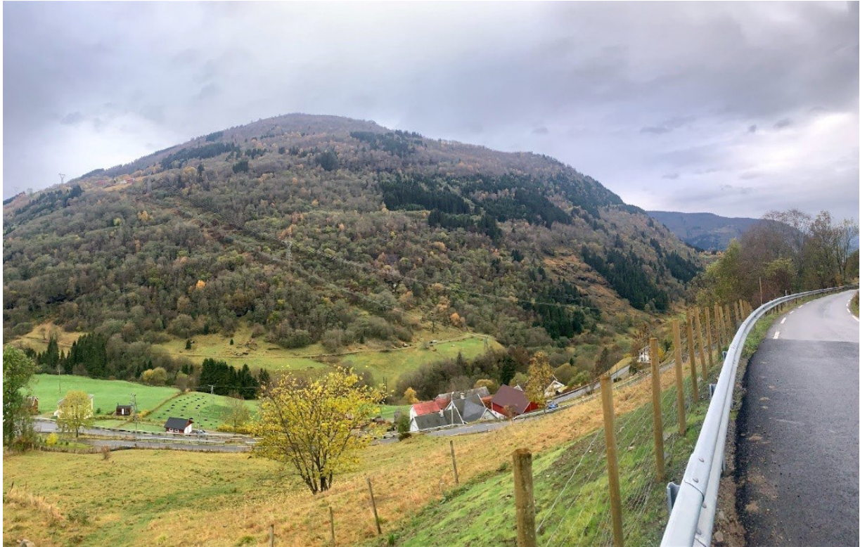
Figur 5 Bildet viser dagens ledning på vei inn i Ovrisdalen etter kryssing av Seljadalen. Kilde: Statnett, 2022.
