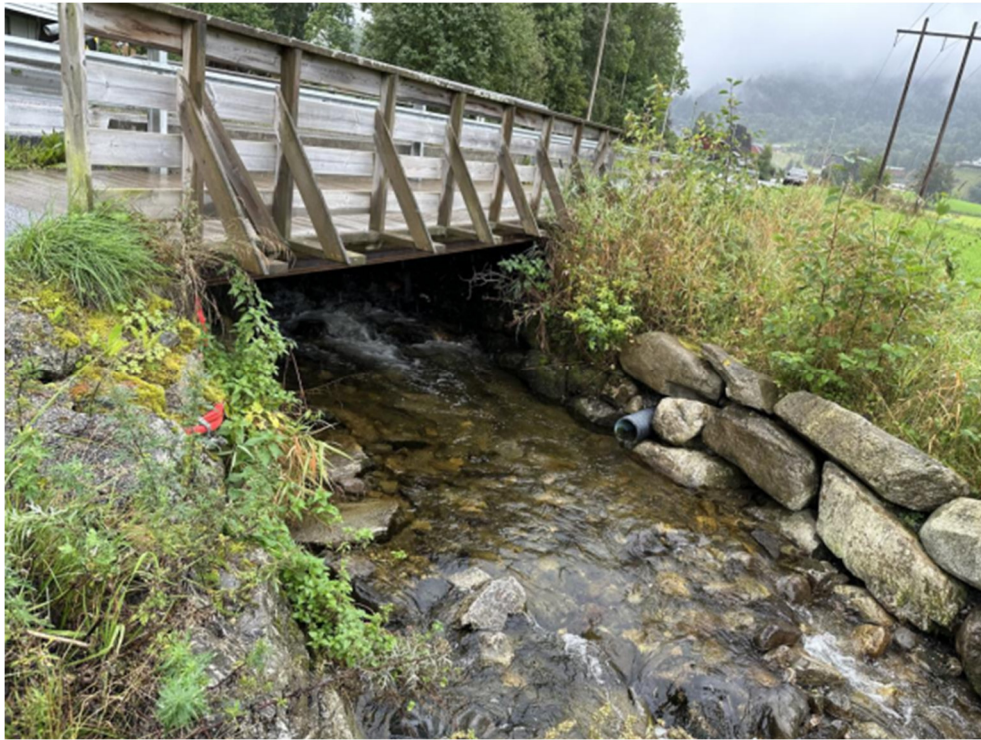
Figur 34: Dagens vei- og gangbru over Vetlaelvi. Kilde: Sweco, 2024.
