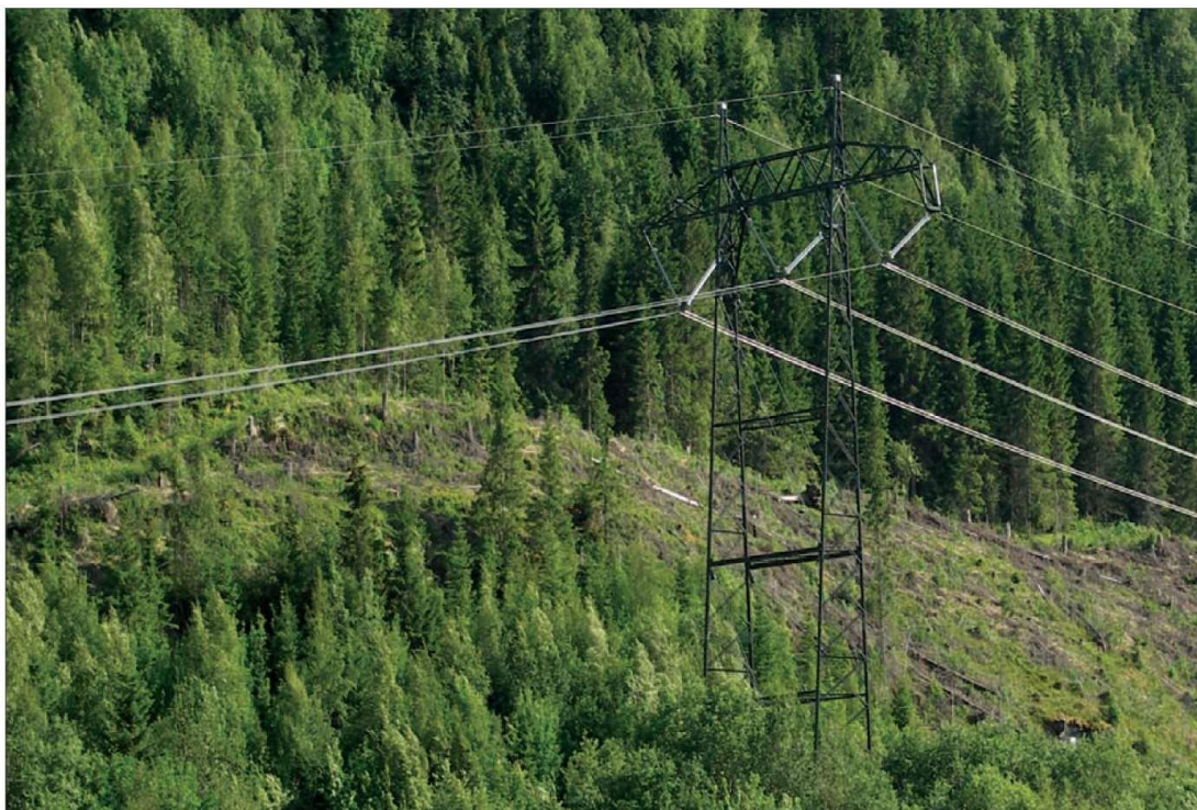
Figur 2-10: Master malt i mørk farge sett mot en skogkledd åsside, her vist med gittermast. (NVE, 2008))
