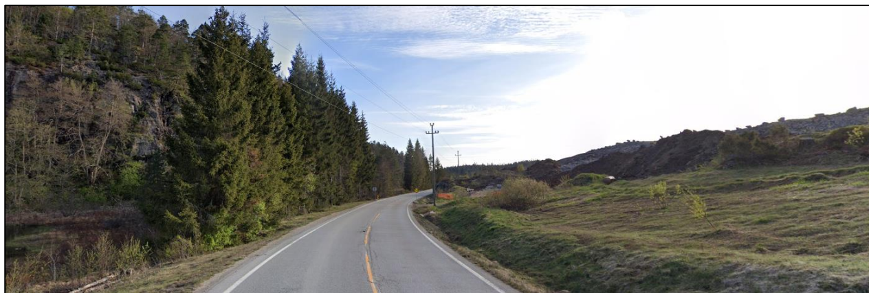
Figur 2-8. Dalbunnen langs Stølevegen. Kilde: Google Street view.
