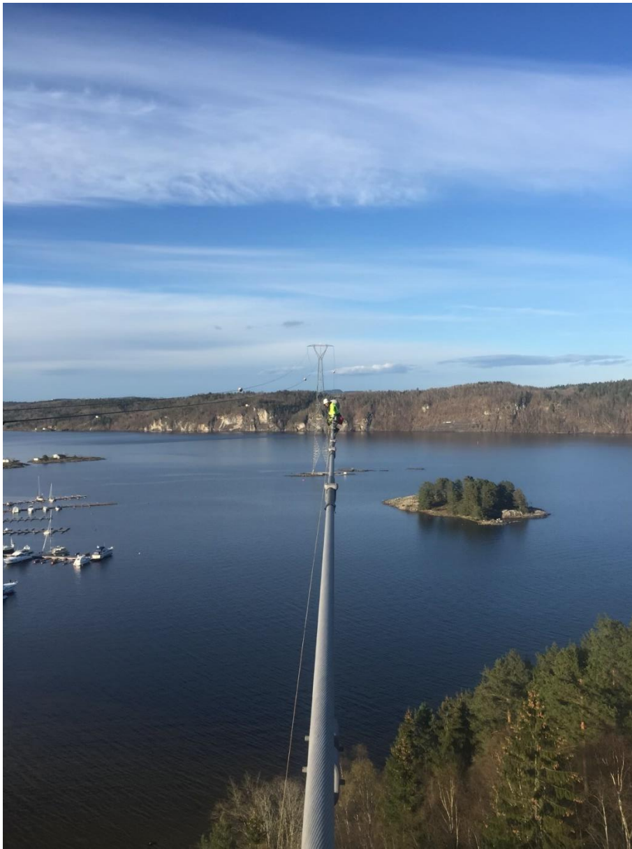
Figur 5 Ved kryssing av Frierfjorden, mellom Bamble og Porsgrunn kommune, meldes det nytt luftspenn sør for eksisterende 300 kV ledning. Nytt luftspenn vil kan inkludere hjelpemast på Garstadhomden som ses i figur over. Bilde: Statnett
