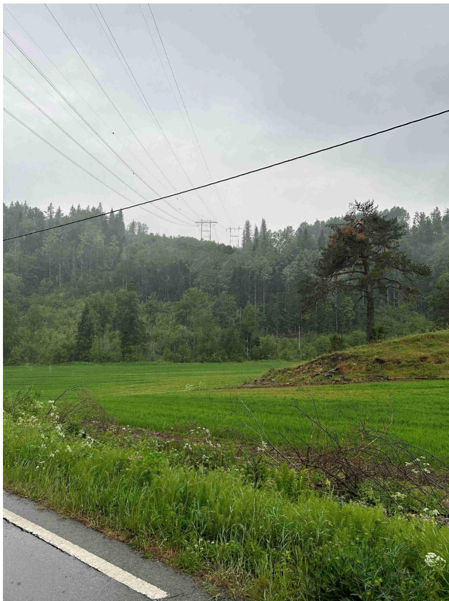
Figur 18 Eksisterende 300 kv og 420 kv sett fra Holtebygdveien i Larvik kommune. Ledningene føres over et kupert terreng.
