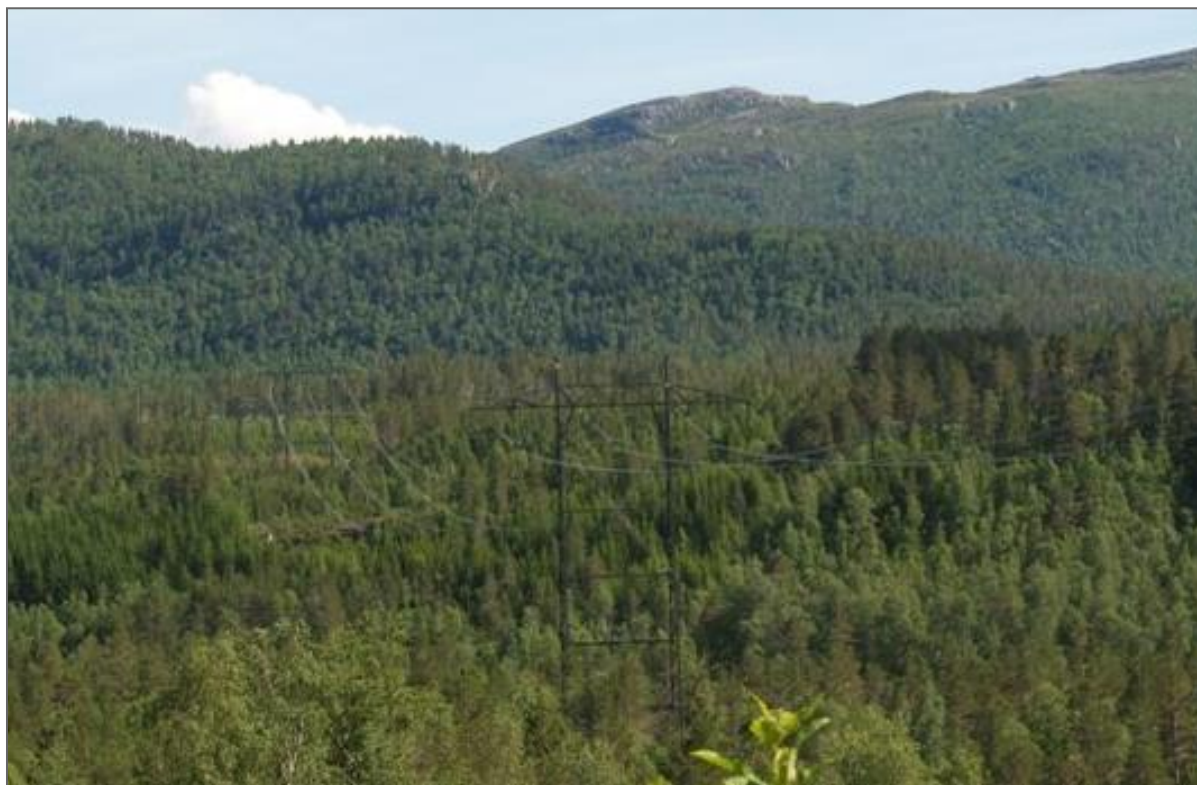
Figur 22 Bilde av kamouflert kraftledning. Linene er mattet, og isolatorene er av kompositt i stedet for av glass som er vanligst å benytte.
