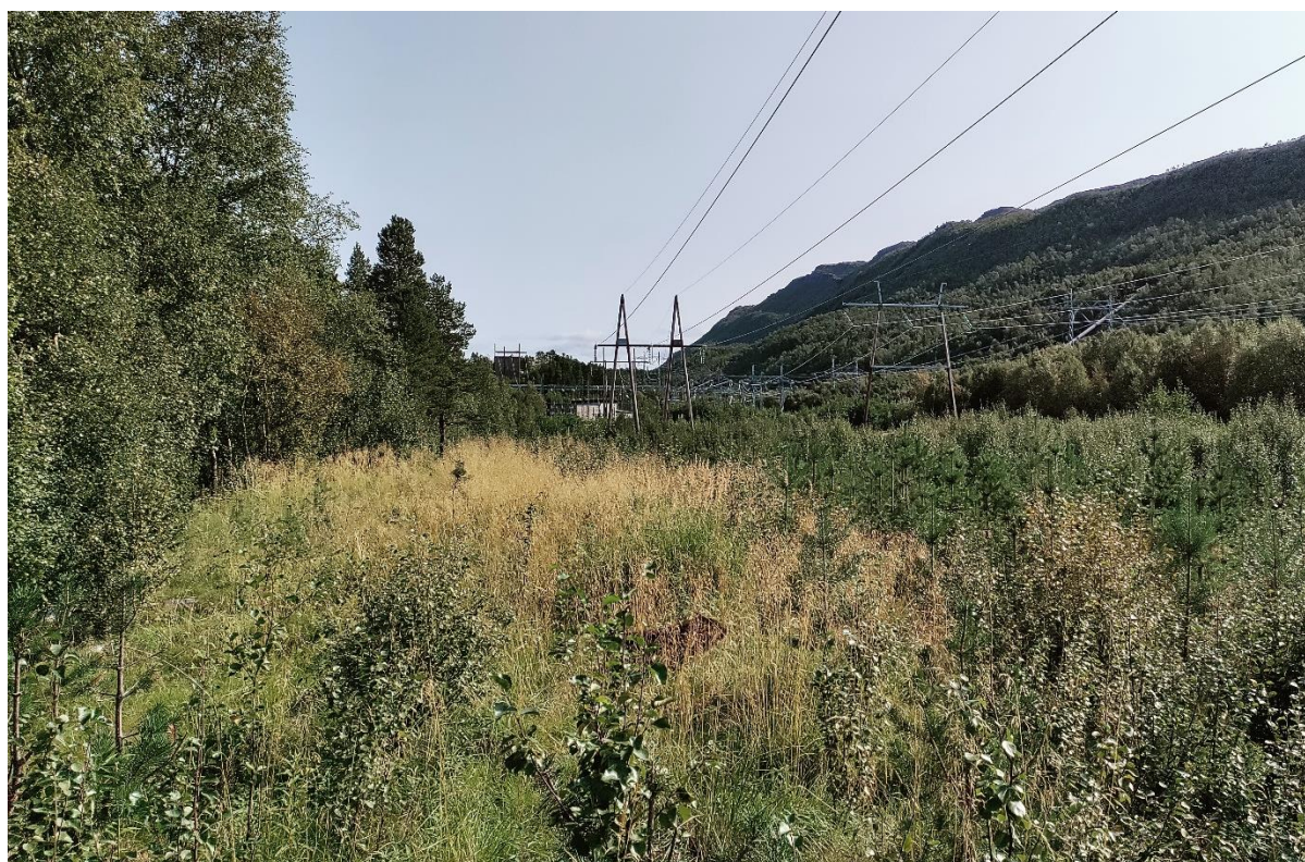
Figur 7 Bildet viser området alt. 2.0 vil ligge, mens alt 2.1 ligger i skogen, helt til venstre av bildet (og videre til venstre). I bakgrunnen ses dagens trafostasjon samt rørledningen som kommer ned fra fjellet. I anleggsfasen vil det meste av trekk forbi dette området stoppe opp og det beste avbøtende tiltaket, uavhengig av alternativ, er derfor å starte anleggsarbeidet så seint som mulig på året.
