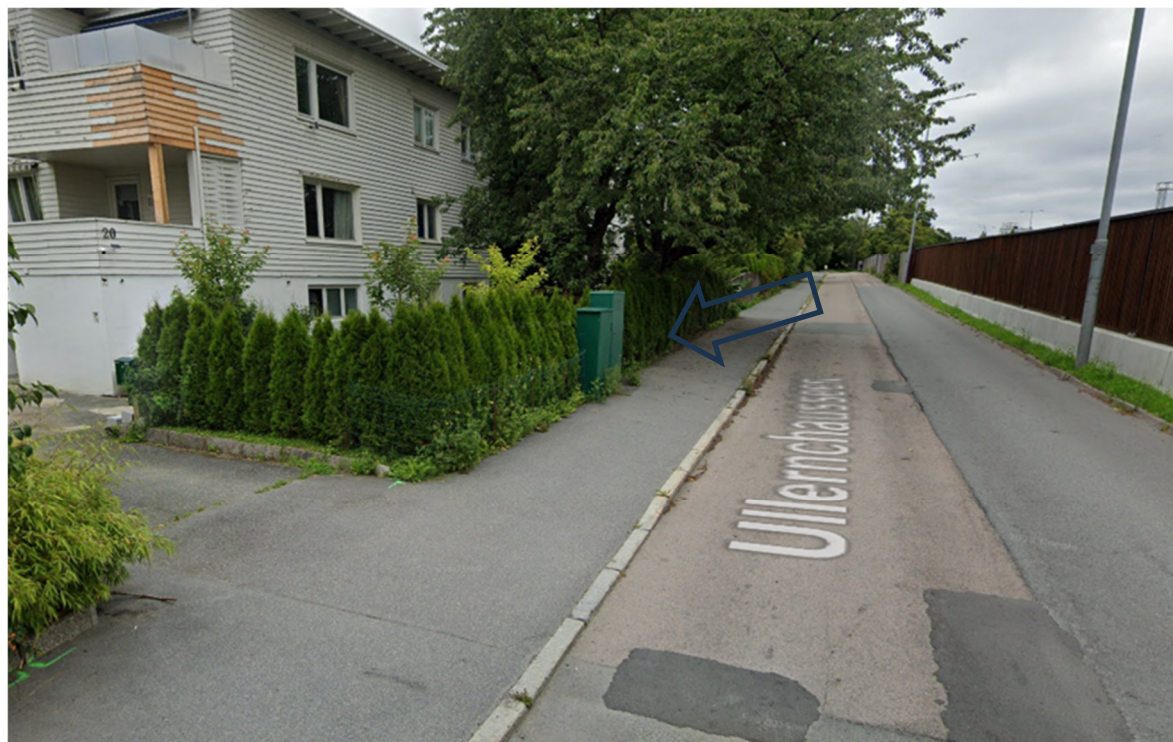
Figur 1 Koblingskap med skjøtekammer i Ullernchaussen.
