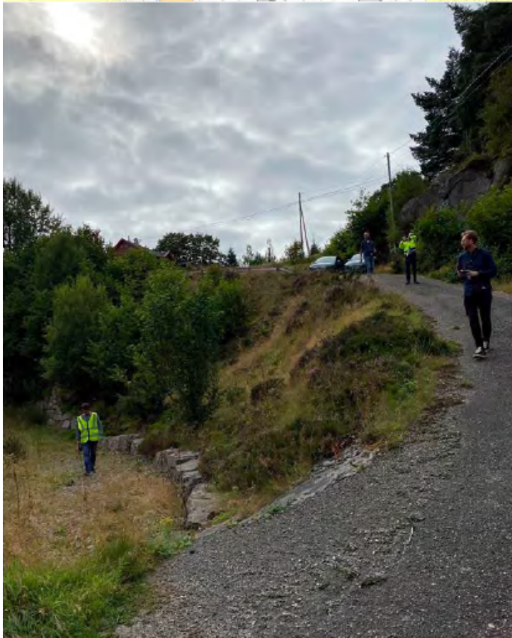
Figur 8: Sikringstiltak ved Dalsvågen. Støttemuren skal fjernes og erstattes med en ny
