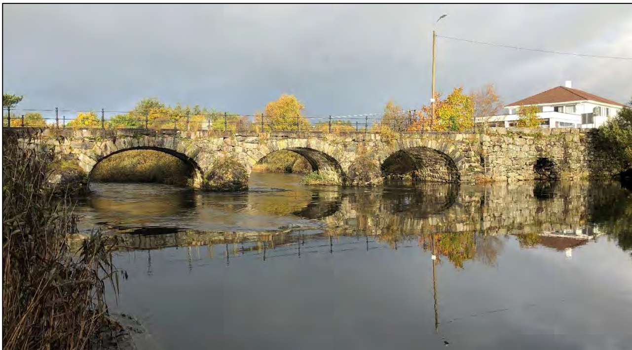
Figur 4-32: Skjæveland bru fra 1853.
