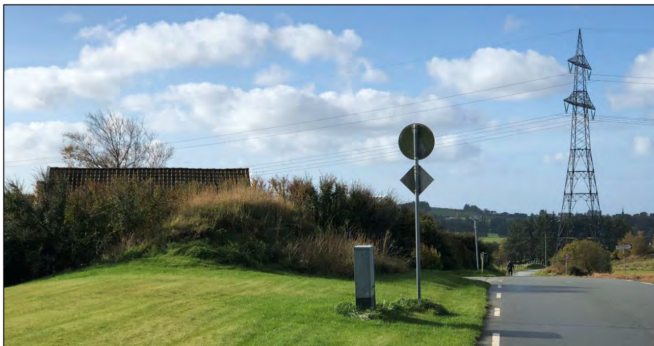
Figur 4-47: Skadet gravhaug på Assheim, bak og til venstre for trafikkskilt.
