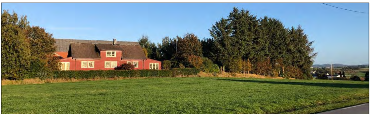
Figur 4-63: Gimra østre, SEFRAK-registrert bolighus fra 1800 tallet, tredje kvartal. Jærhus – sidefløyene er en historiserende tilføyning fra 2000-tallet.
