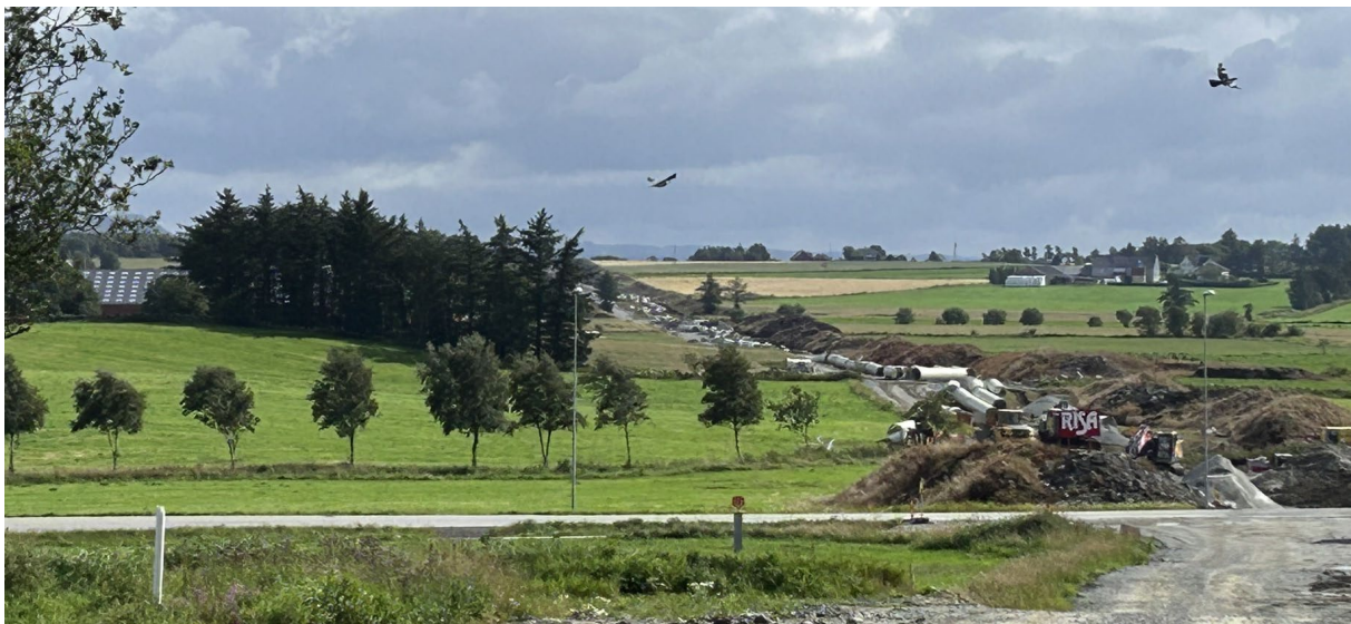
Figur 15 Fra arbeidet med ny hovedvannledning ved Heigreveien sett mot sør.
