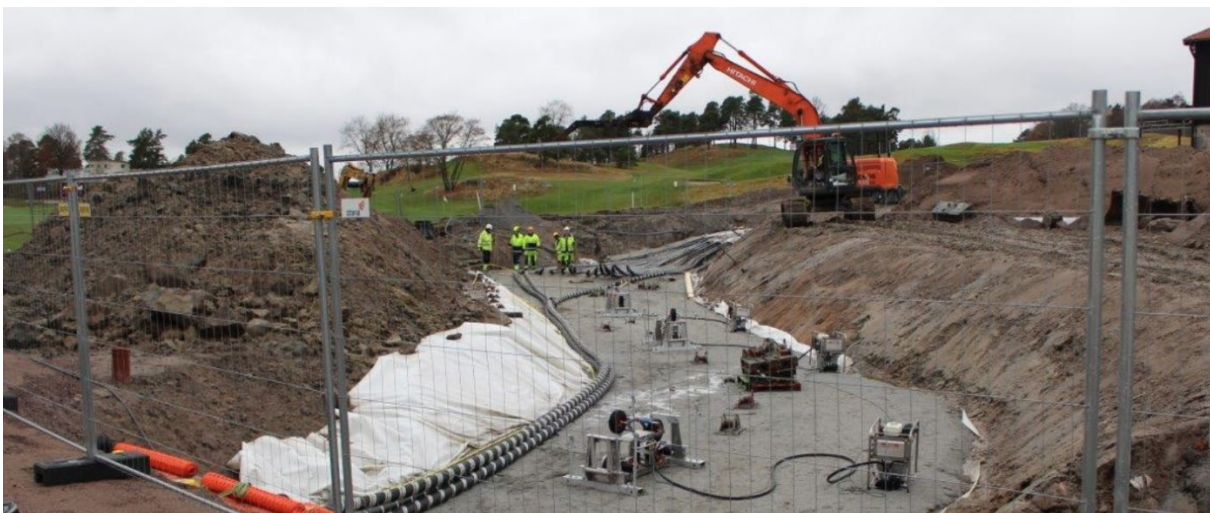
Figur 13 Typisk bilde fra kabelleggingen.
