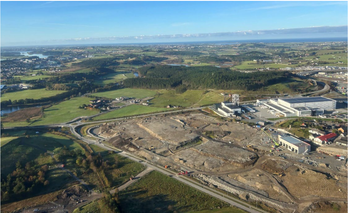
Figur 17 Anleggsarbeid på næringsområdet på Vagle september 2023.
