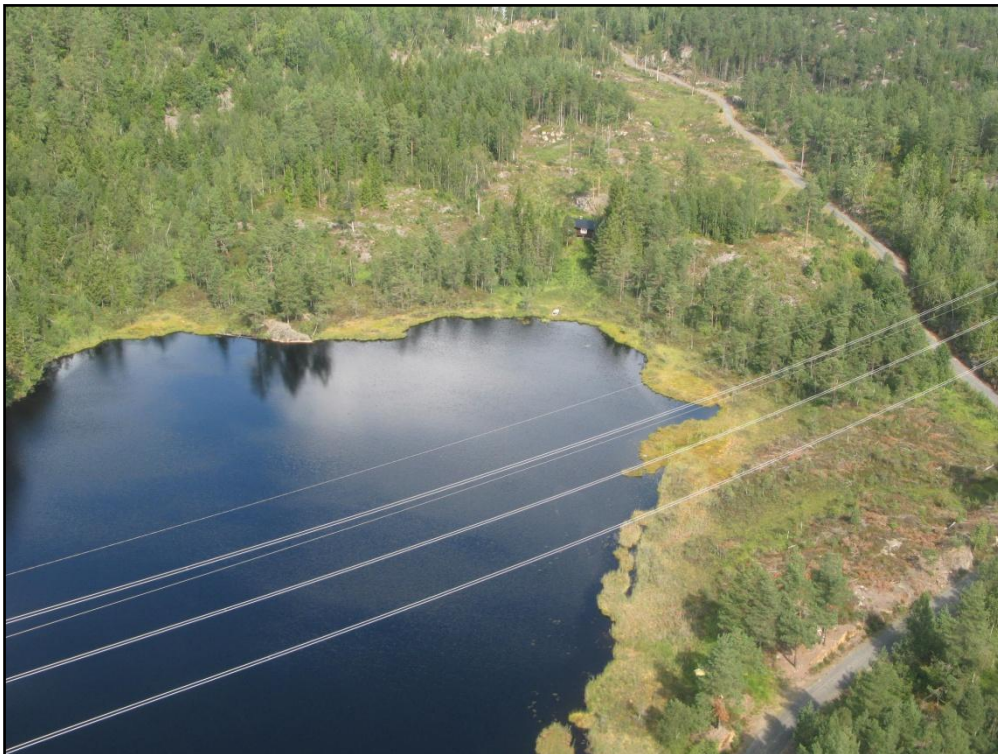
Figur 14. Planlagt lokalisering av Bamble transformatorstasjon, alternativ Mo, i bakgrunnen.
