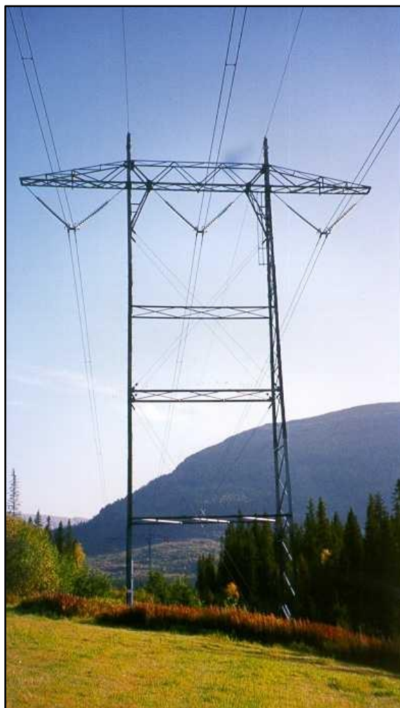
Figur 4. Meldt mastetype. Statnetts 420 kV portalmast (innvendig bardunert).
