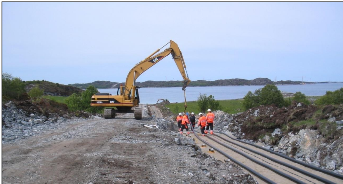
Figur 19. Bildet viser kabelgrøften på land for 420 kV-forbindelsen som ble lagt i forbindelse med Ormen Lange-prosjektet (ett kabelsett + én reservekabel). En forbindelse med tilsvarende kapasitet som en 420 kV luftledning må ha minst to kabelsett (seks kabler) og tilsvarende bredere grøft. Foto: Statnett.
